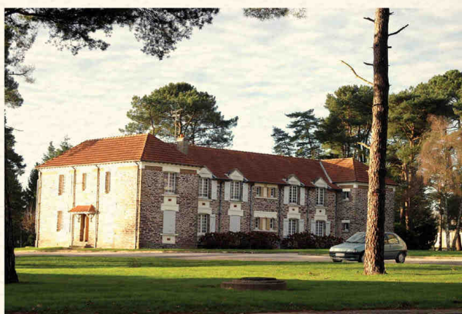
L'ancien camp bâti conserve, aujourd'hui, une architecture patrimoniale
